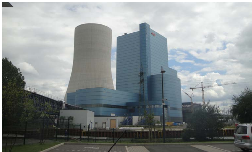
Baustelle des Steinkohlekraftwerks Datteln IV
